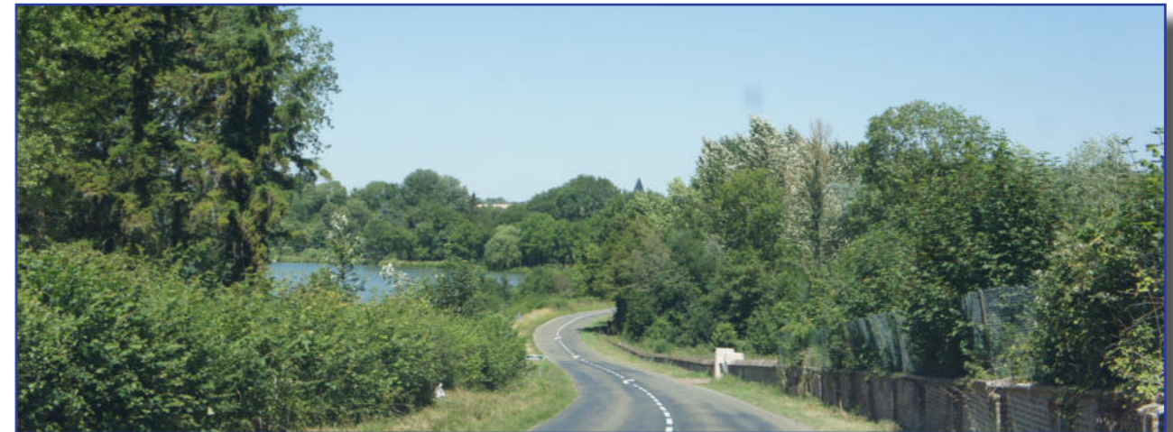
Site classé de Caulaincourt - vallée de l'Omignon - RD34.
