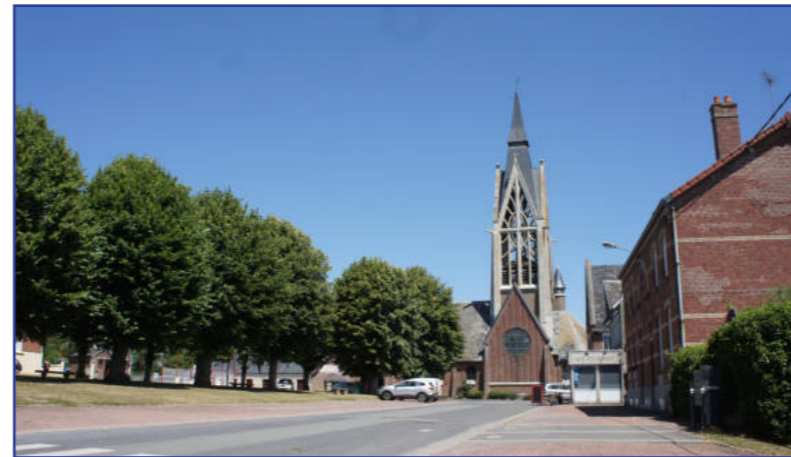
Eglise de Vermand - architecture typique de la reconstruction, alliant brique et les éléments décoratifs en béton.
