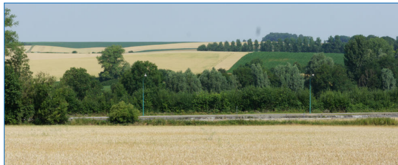
Le canal du Nord (au milieu des arbres) au nord de Moilains : bois, rideau d'arbres, berges plantées, coteaux marqués.
